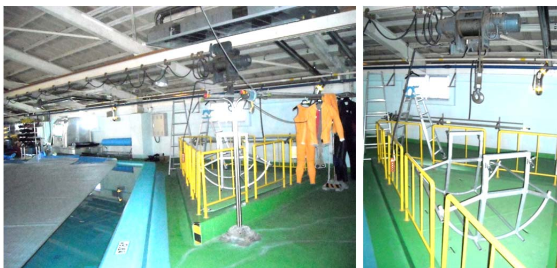
2階プールフロア（プールにはカバーがかけられている。柵で囲われているのが開口部。上にクレーンが見える。）
